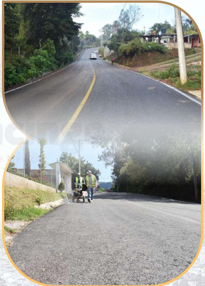
Primera etapa de la rehabilitación de carretera con concreto asfáltico en la localidad de Ixpuchiapan.
